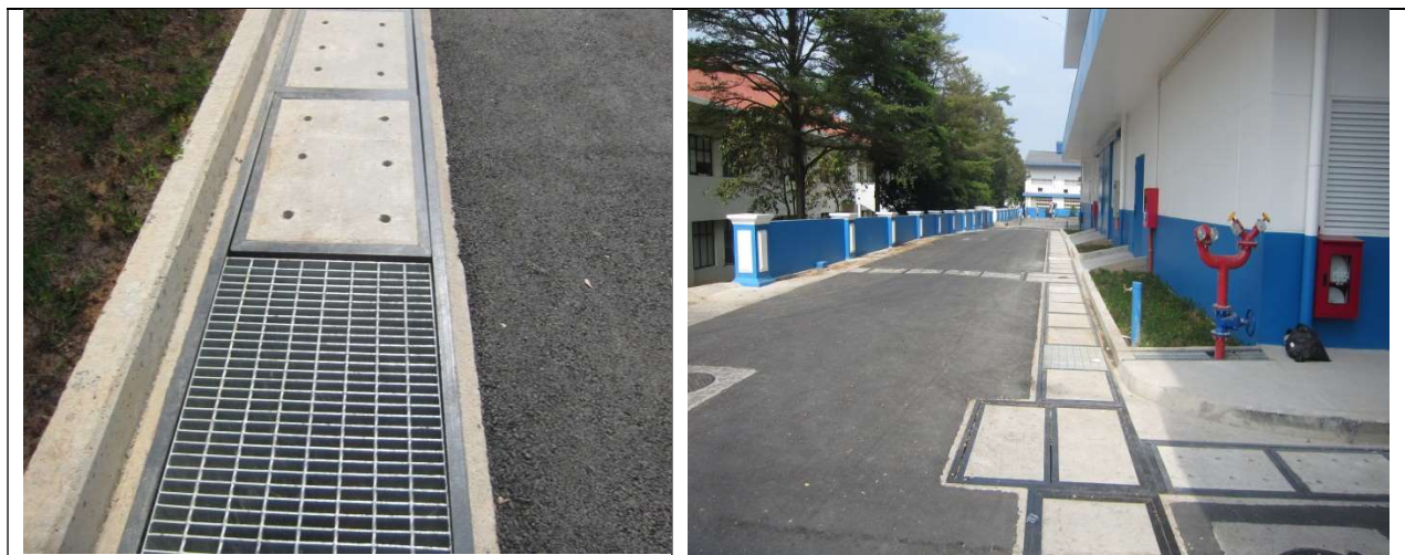
Hệ thống thoát nước mưa
